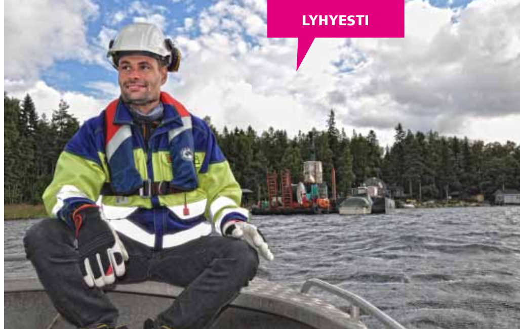
Vaasan Sähköverkon rakennuttaja Kai Pokela tarkkailee työn etenemistä veneen kyydistä.
